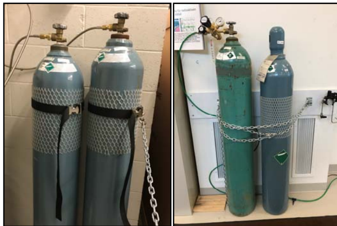
Figure 9 – Arrimage des bouteilles de gaz comprimé
