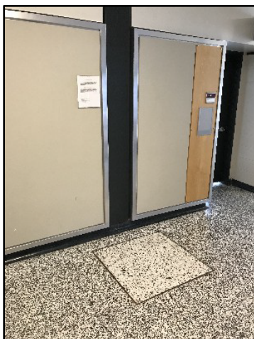
Figure 3 – Exemple de point d'accès à la galerie (Block B)
