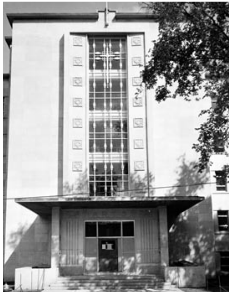
Entrée de rue Waller du pavillon des arts. 82
