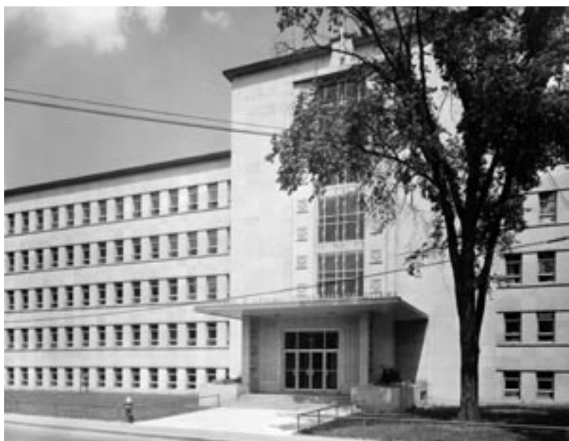
La Faculté de droit était située au quatrième étage du pavillon des Arts (pavillon Simard) 37
